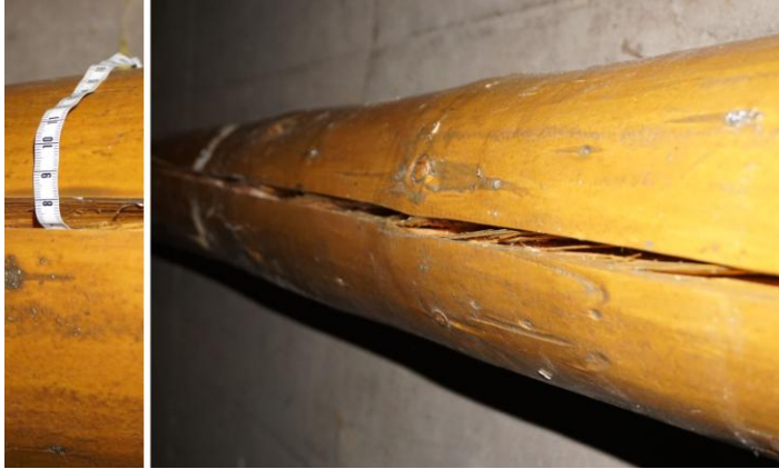
Zu breit, zu tief, zu lang – der Riss gefährdet die Standsicherheit – Foto: Volkstanzgruppe Thune
