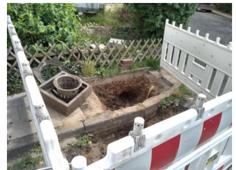
„Runderneuert“: Gulli mit Sickerschacht in der Geibelstraße
