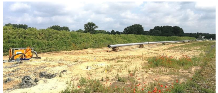
Zu verlegende Rohre, Foto: Gerd Knoke
