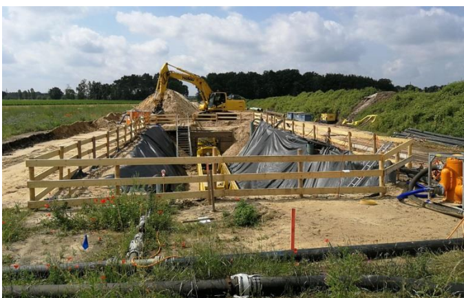
Baustelle zwischen Harxbüttel und Thune, Foto: Gerd Knoke
