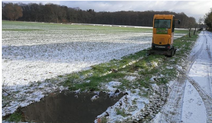
Erdarbeiten für die neuen Bäume – Foto: G. Knoke
